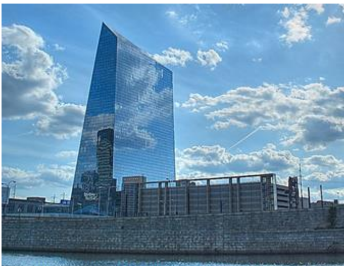
El Cira Center en la ciudad de Filadelfia, Estados Unidos, con rasgos de la arquitectura invisible (Pelli Clark Architects: 2016)
