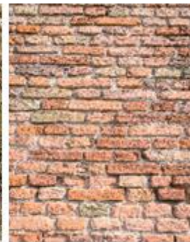
Muro de Ladrillo
