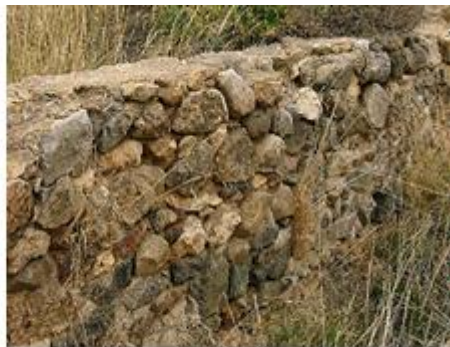
Muro de Mampostería
